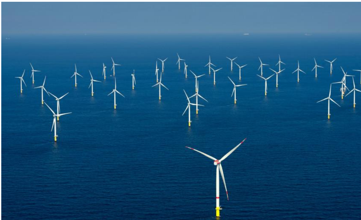
Baltica s výkonom približne 2,5 GW bude najväčšou veternou elektrárnou na Baltskom mori
